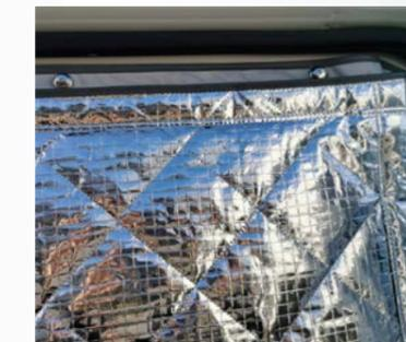
Fixation de l'isolant sur la grille
